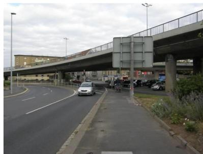
**10:** In der Schweinfurter Straße muss der Wechsel der Radwegführung verbessert werden. Getrennte Geh- und Radwege (als durchgängige Führungsform) und vor allem kein Wechsel von links nach rechts (Piktogramme). Des Weiteren muss der Lieferverkehr geregelt werden. Die Situation könnte durch eine Verschiebung der Busbucht als Insel in die zweite Spur von innen erfolgen und verbessert werden.
